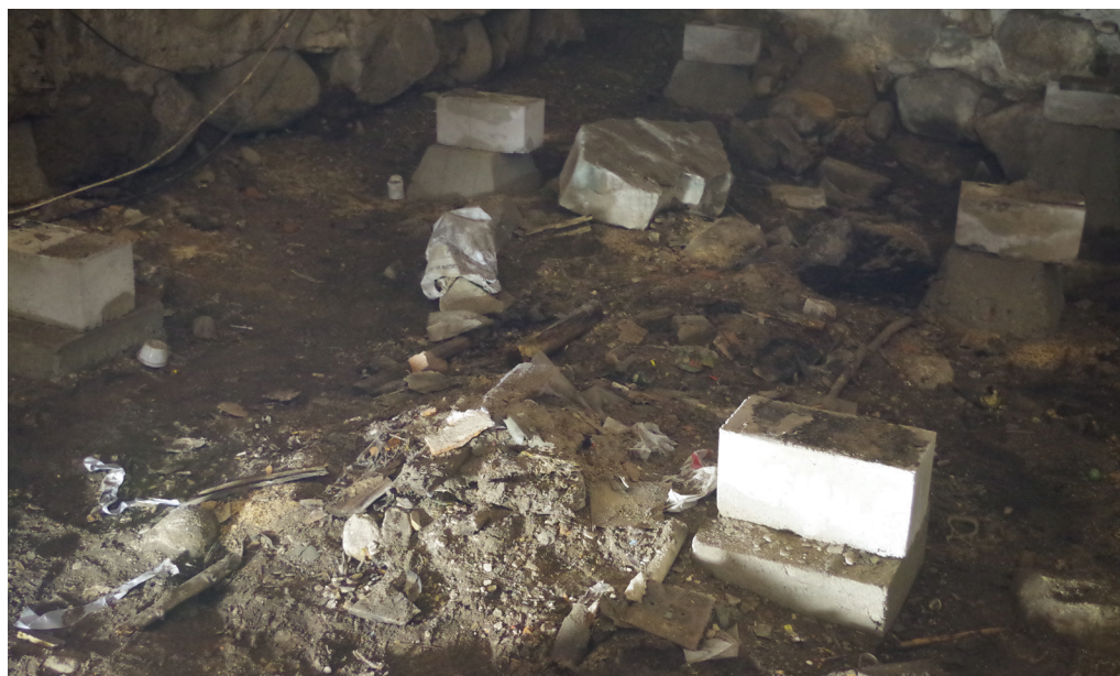
Figur 5 visar ett foto av en hög med recent byggmaterial och skräp i Borgstugans sydöstra del. I fotot syns även några av 1900-talets nedgrävda, koniska betongplintar. Foto: Åsa Alering.
